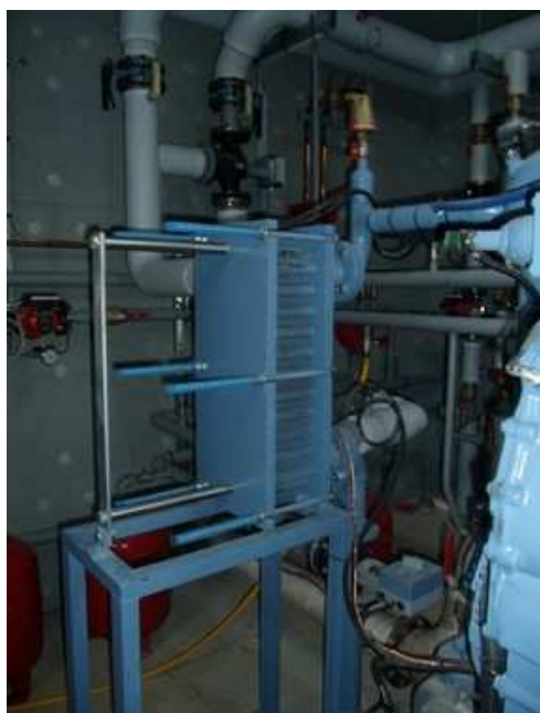
7 Echangeur à plaques pour récupérer l'eau chaude sur le circuit de refroidissement du cogénérateur
